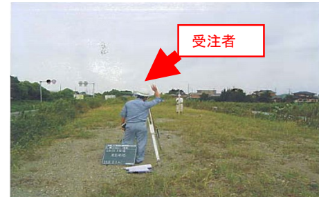
(現場状況の照合を実施)
