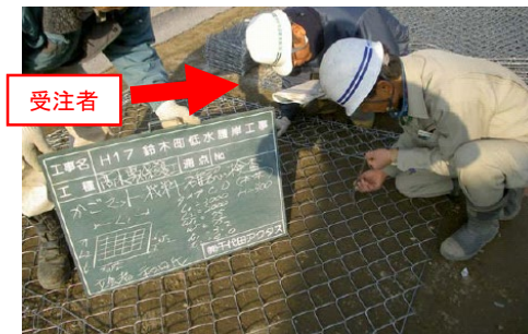
(河川護岸用かごマットの材料確認)
