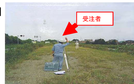
(現場状況の照合を実施)
