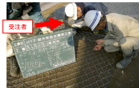
(河川護岸用かごマットの材料確認)
