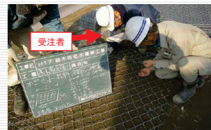
(河川護岸用かごマットの材料確認)
