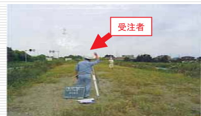
(現場状況の照合を実施)
