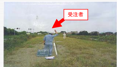
(現場状況の照合を実施)
