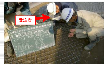
(河川護岸用かごマットの材料確認)
