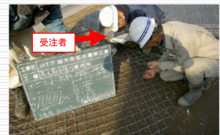
(河川護岸用かごマットの材料確認)
