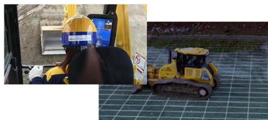
ICT建機による施工
