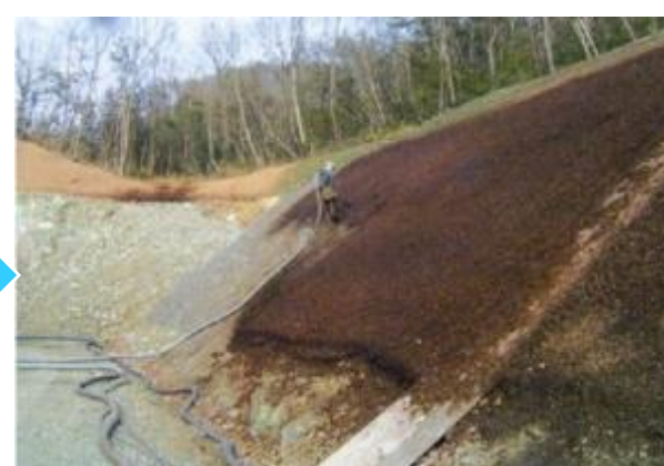
現場内で法面工などに再利用
