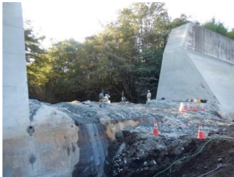
コンクリート削孔による先行掘削
