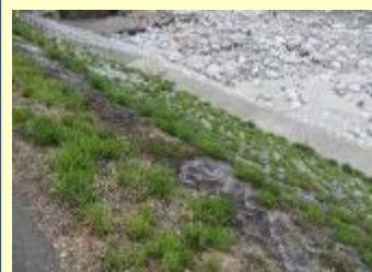
石張り護岸の状況（除草）
