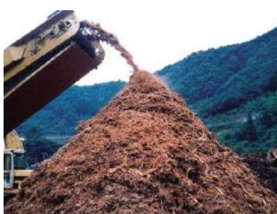
現場内で破砕処理
