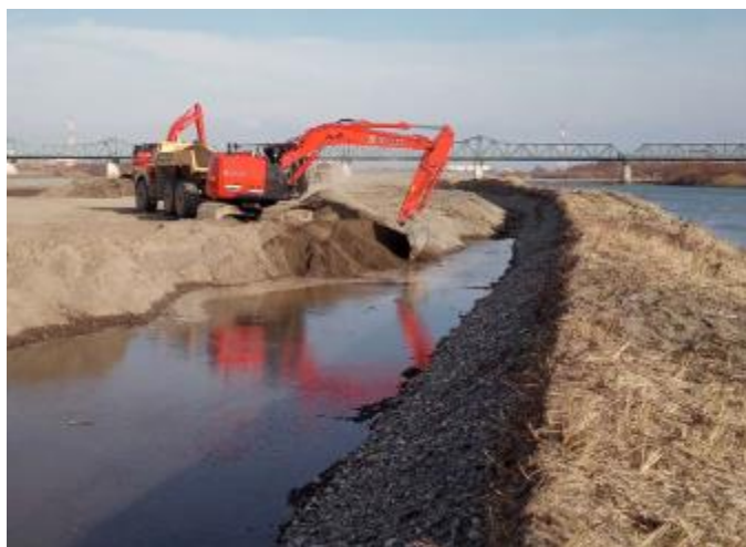
河口部付近における河道掘削の施工状況
