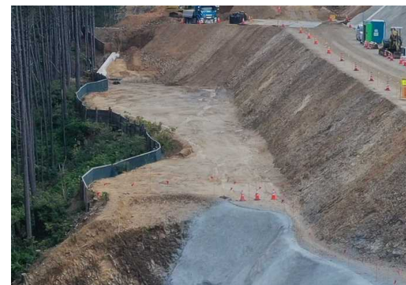
余地が無い場合の現在の対応 (土砂流出防止効果は限定的)
