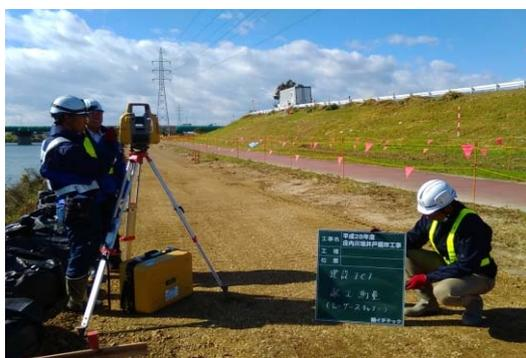
LS(レーザースキャナー)による起工測量
