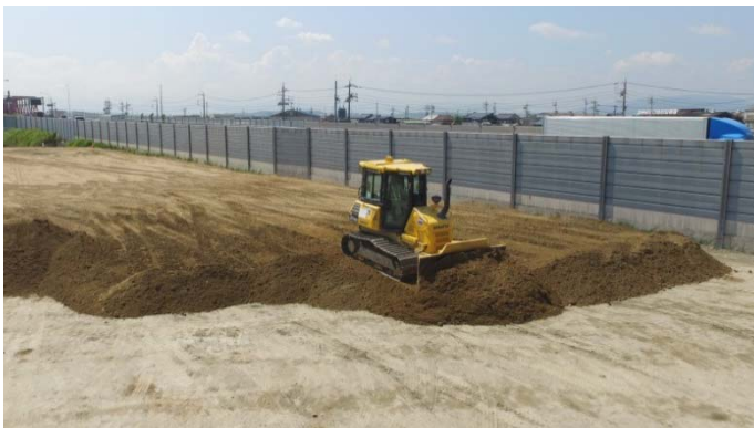
ICTブルドーザによる敷均し(8月19日)
