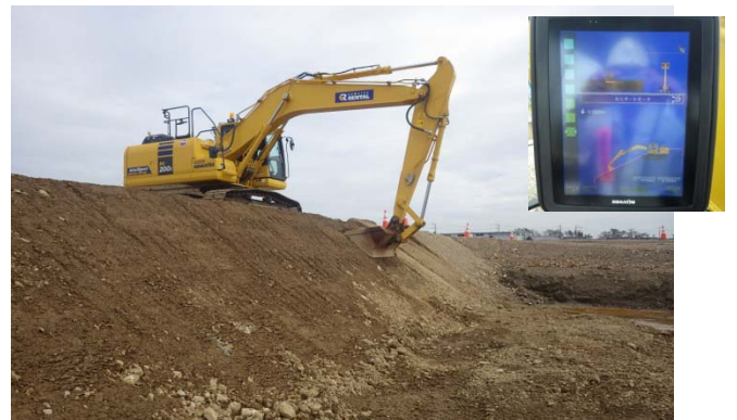
ICTバックホウによる法面整形(9月27日)
