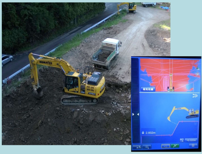
MCバックホウによるICT土工
