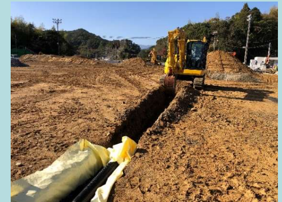
0.28m 3 級BH(幅狭バケット装着)
