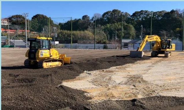
グラウンド下層部(RC-40)の施工状況と出来形
