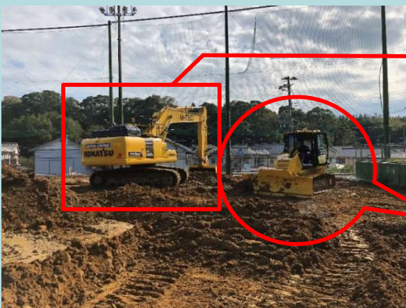
ICTバックホウ(0.8m 3 級)によるすき取りとICTブルドーザによる基面整正
