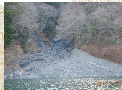
重点点検箇所 桂沢 (土砂・流木の流出状況を確認) ※上流部砂防ダムが堆砂状態。 土砂流入状況を継続監視。
