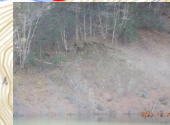
変状箇所-18 (法面崩落状況を確認)
