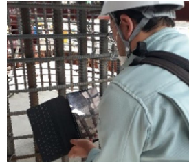
例) 配筋検査の効率化
