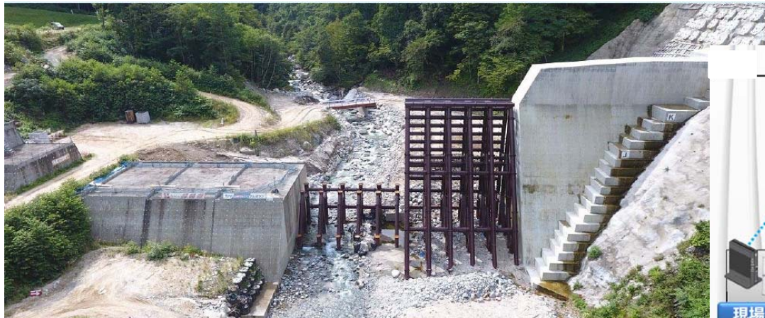
「多治見砂防国道事務所 HP内資料より」
