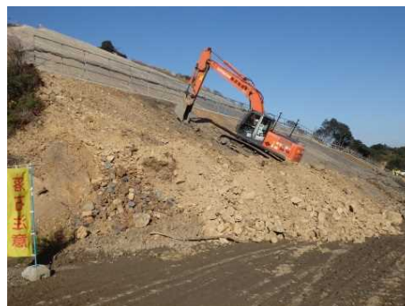
長大法面・流れ盤での掘削
