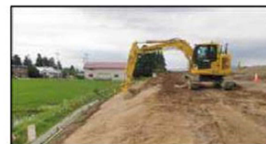
ICTバックホウによる法面整形
