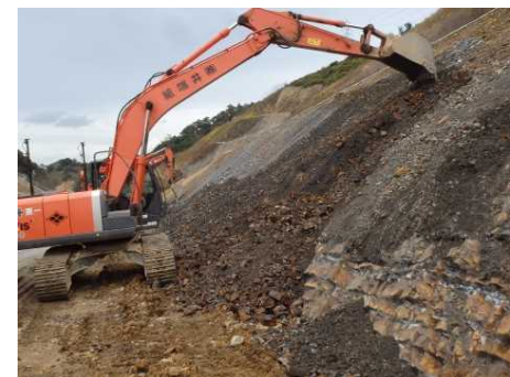
長大法面・流れ盤での掘削
