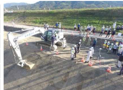
3DMGバックホーによる法面整形
