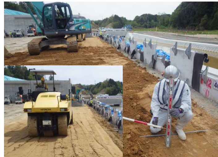
補強土壁工（盛土）施工例
