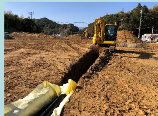
0.28m 3 級BH(幅狭バケット装着)
