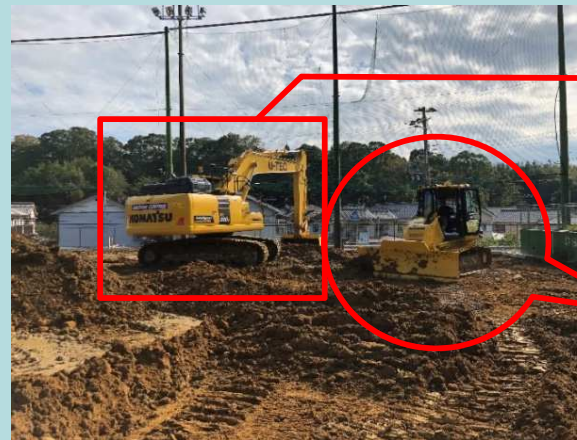
ICTバックホウ(0.8m 3 級)によるすき取りとICTブルドーザによる基面整正
