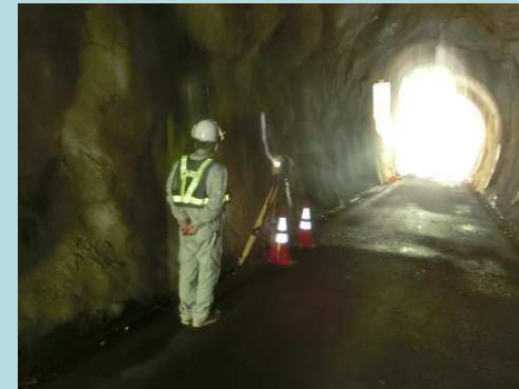
TLSによる測定状況
