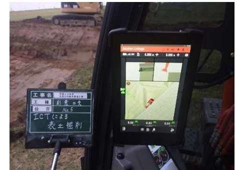
掘削作業状況
