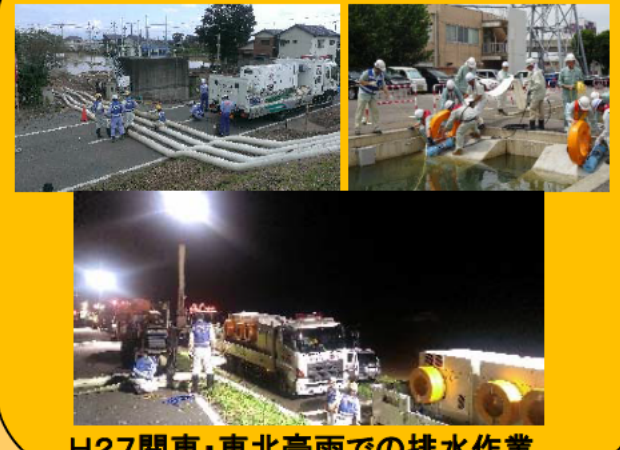
H27関東・東北豪雨での排水作業
