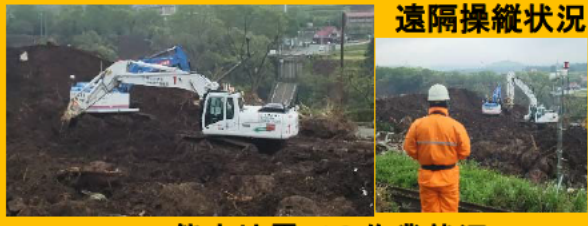
H28熊本地震での作業状況
