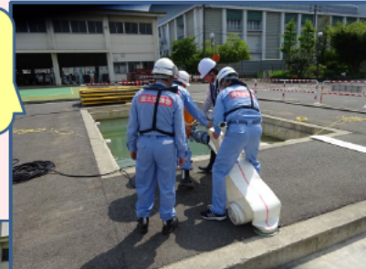
排水ポンプ車 設営体験を通して、各構成機材の 役割とその重さを実感。 実際に排水作業も行いました。
