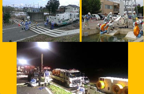
H27関東・東北豪雨での排水作業
