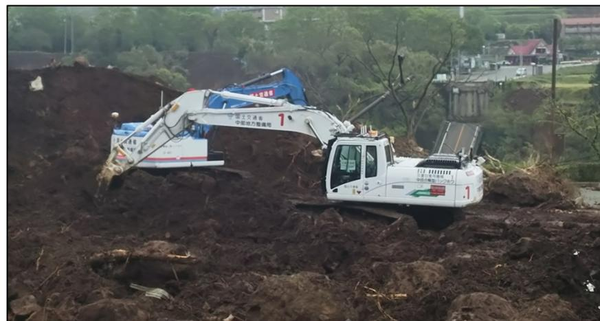
遠隔操作で土砂排除作業中の無人化施工バックホウ(阿蘇大橋崩落現場)
