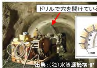
掘削面を吹きつけコンクリート、ロックボルトで支持
