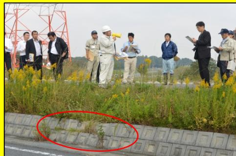
堤脚保護工(間知ブロック空積)の損傷
