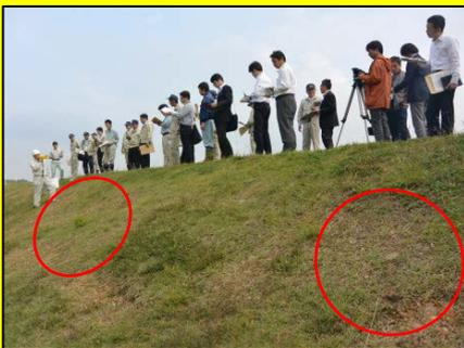
堤防法面(張芝の傷み)の損傷
