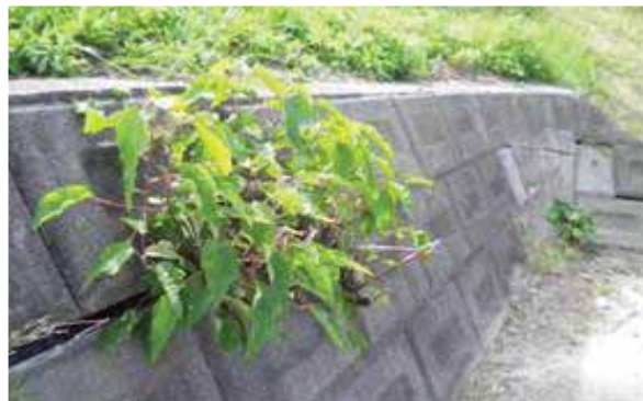
堤脚ブロックのズレ、はらみだし
