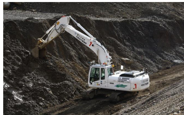
遠隔作業状況(H25年の「台風18号被害の災害復旧活動」(奈良県五條市))
