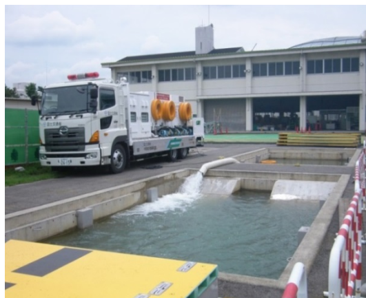
排水ポンプ車による排水訓練
