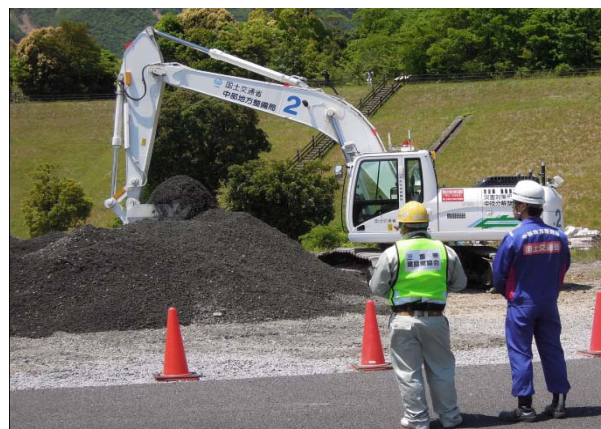
無人化施工バックホウ(遠隔操縦式) 災害により土砂崩落したような危険な復旧現場へ派遣を行い、作業の安全を確保します
