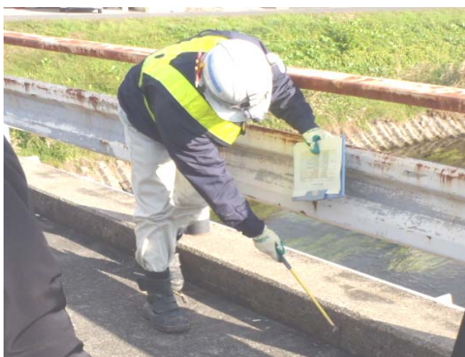
【現地研修】ハンマーによる打音点検
