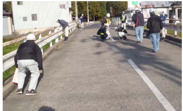
【現地研修】橋面に異常が無い点検する参加者
