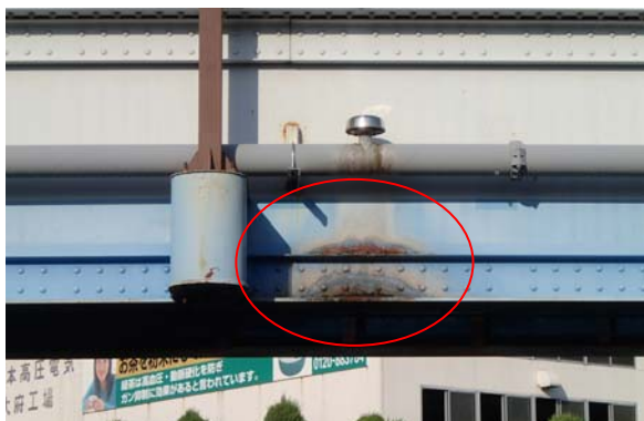
【現地研修】確認した損傷(桁の腐食)
