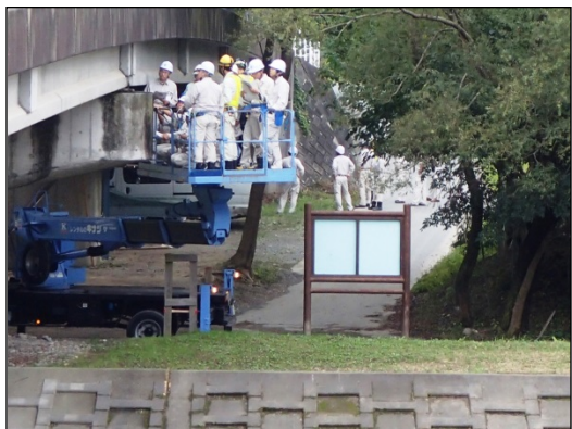
【現地研修】リフト車にて上部工での点検ポイント確認
