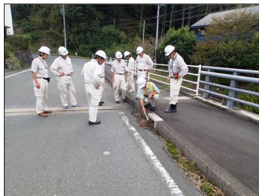
【現地研修】橋上での点検ポイントの確認
