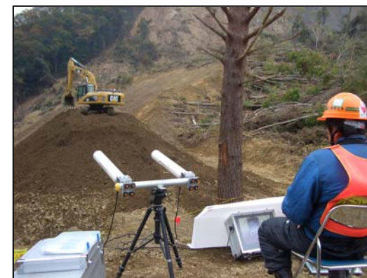
遠隔作業状況(H23紀伊半島大水害にて) ※同一機械であるが当時は塗装が異なる
