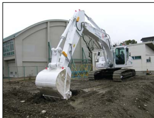
無人化施工バックホウの外観
