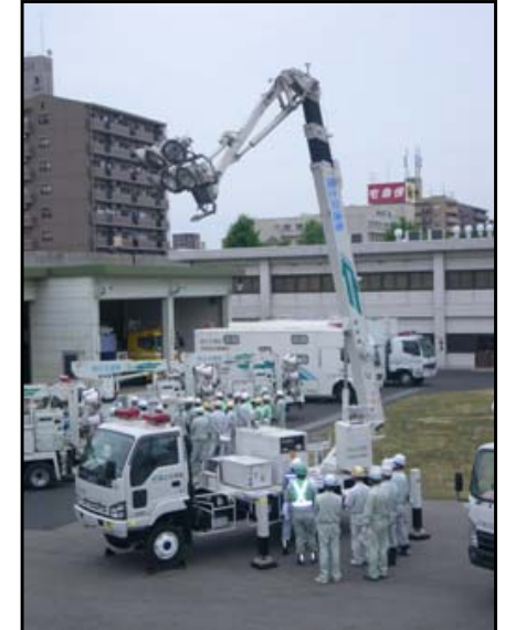
照明車の設置・点灯訓練
