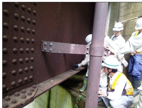
【現地研修】 桁端部での点検ポイントの確認
