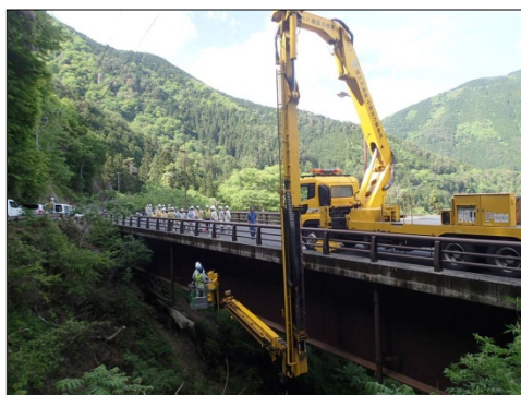
【現地研修】 橋梁点検車にて床版下面の確認
