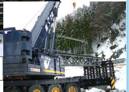
平成16年台風23号災害 岐阜県飛騨市宮川町内 国道360号の迂回ルートとして架設された応急組立橋
