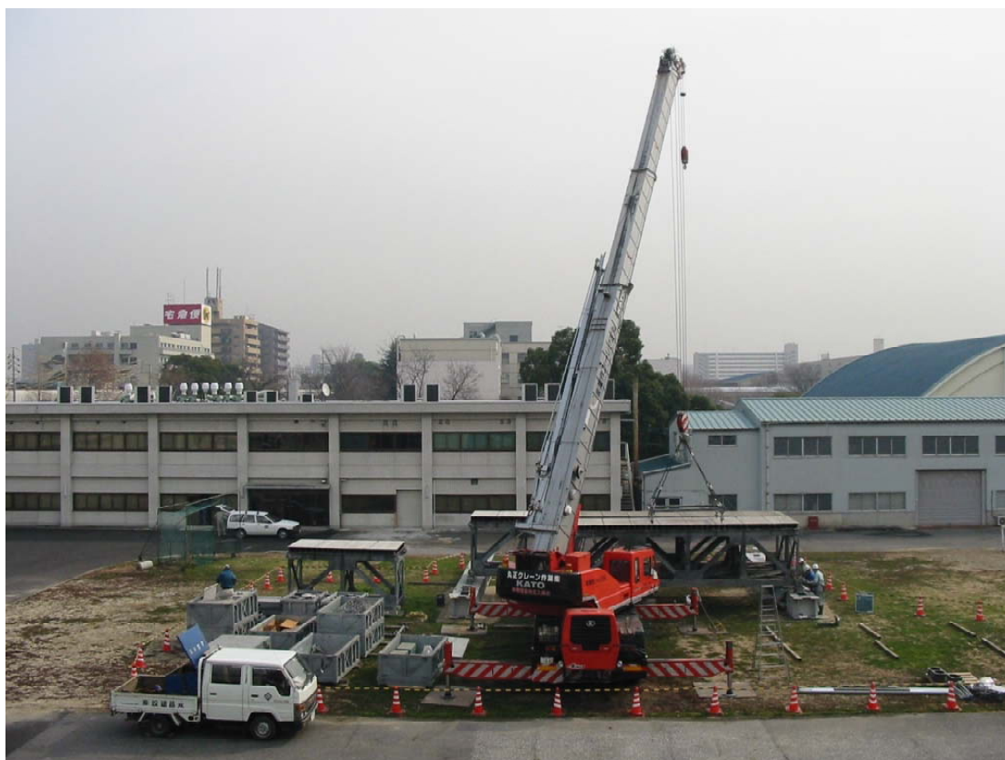
過去の架設作業状況写真
