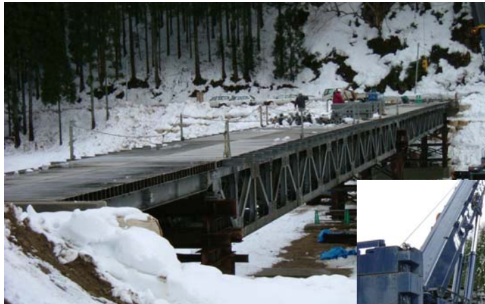
平成16年台風23号災害 岐阜県飛騨市宮川町内 国道360号の迂回ルートとして架設された応急組立橋
