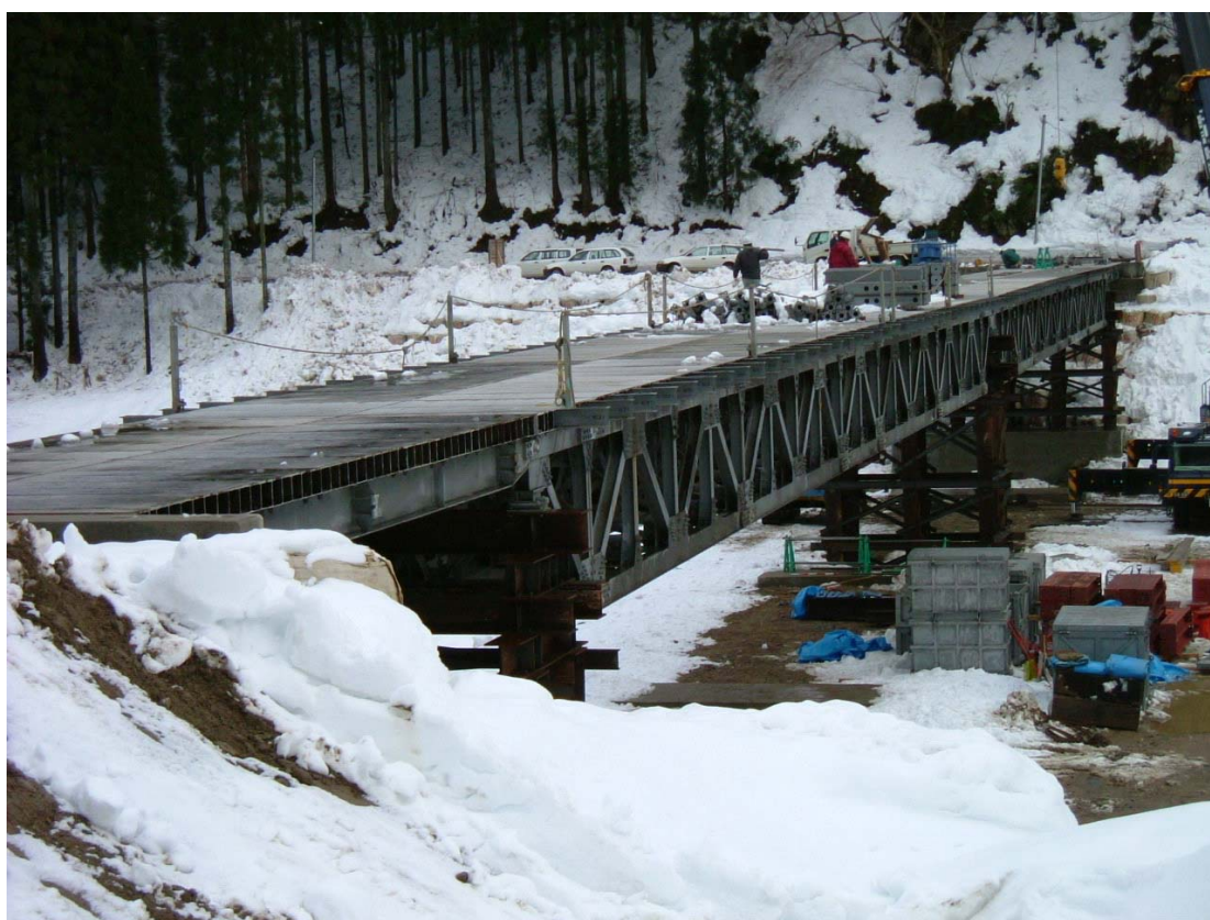
過去の架設完了状況写真
