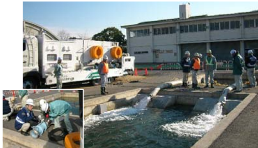
排水ポンプ車： 構内の訓練用水槽にて ホース接続から実排水まで一連の作業を訓練
