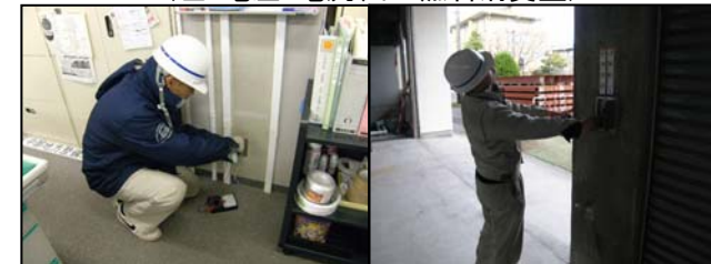
給電状況確認(左：庁舎コンセント、右：車庫シャッター)
