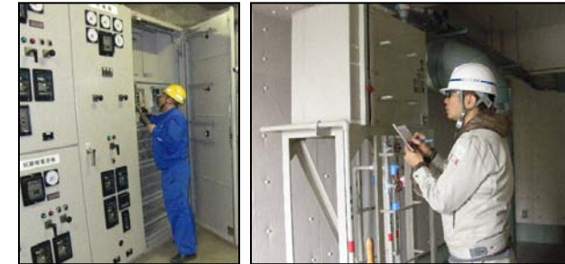
発電機稼働状況確認 (左：電圧・電流、右：燃料消費量)
