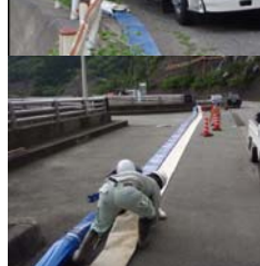
ホース延長600m設置
