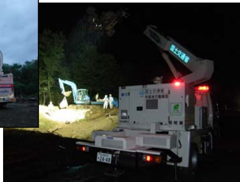
復旧作業を照射する照明車
