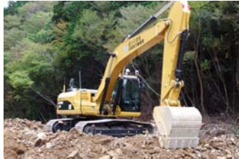
遠隔操作状況
