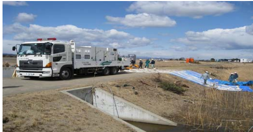
平成22年度 東日本大震災(仙台空港)での活動状況
