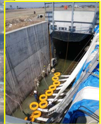
トンネル部の排水作業
