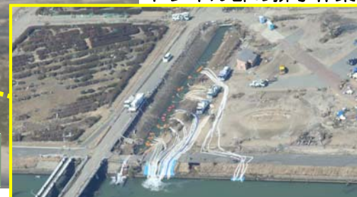
排水ポンプ車による排水作業
