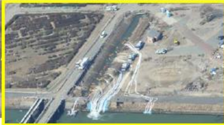
排水ポンプ車による排水作業
