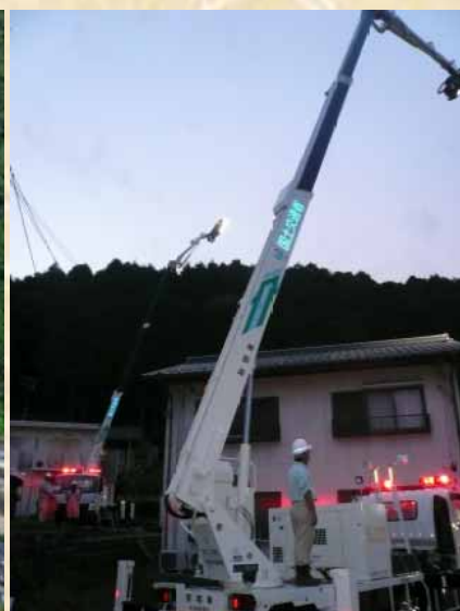
19:00 照明車設置完了
