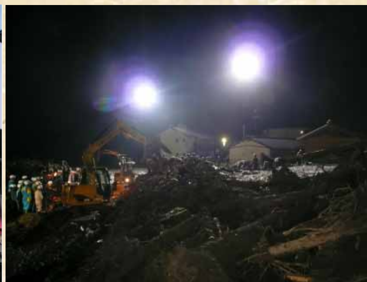
20:50 照明点灯による夜間救出作業
