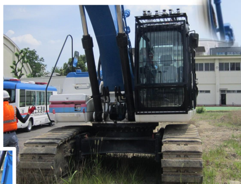
【↑カメラ取付状況】
