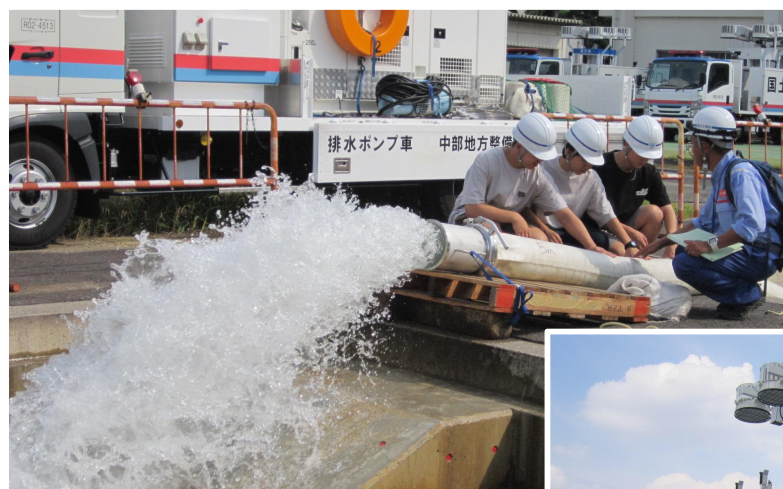
【↓排水ポンプ車 設営体験】
