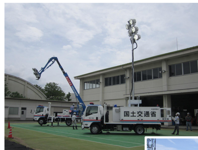
【照明車設営訓練状況】
