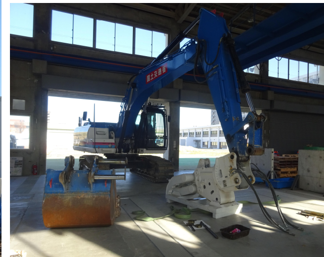
バケットからつかみ機への交換作業
