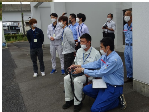
無人化施工(遠隔操縦式) バックホウ
