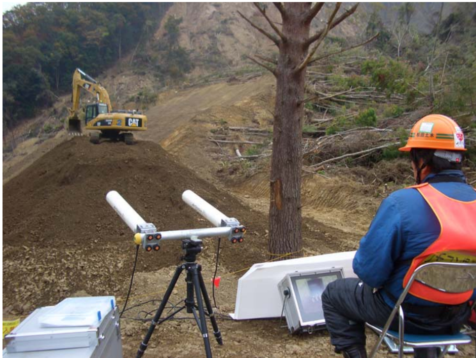
遠隔作業状況 (H23台風12号奈良県にて)
