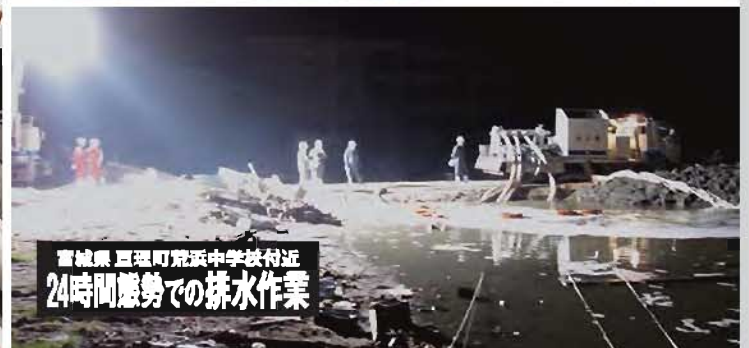
北陸地方整備局から派遣された 排水ポンプ車
