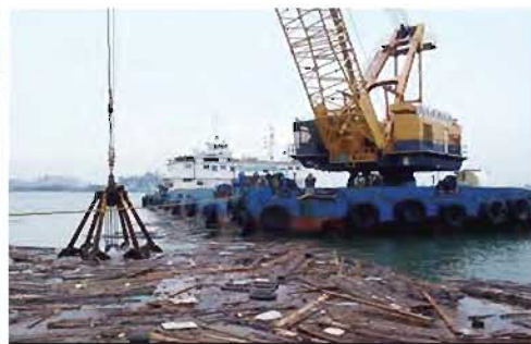
航路啓開状況・石巻港 (流出した木材の除去)
