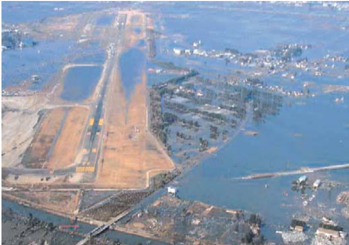
津波により浸水した仙台空港
