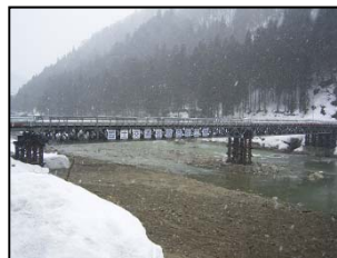
平成16年度 岐阜県飛騨市における応急架設
