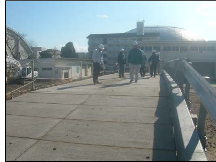
架設した応急組立橋で施工手順を確認
