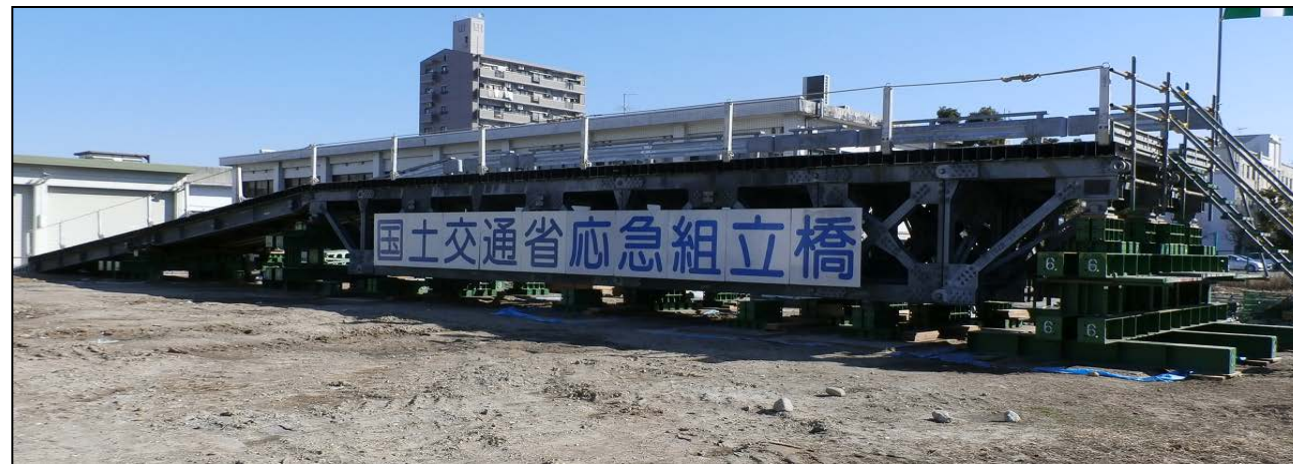
中部技術事務所構内に架設
